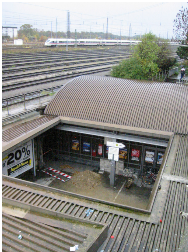
Abb. 1: Ansicht des Lichthofs und Einhausung des Straßentunnels von oben.
