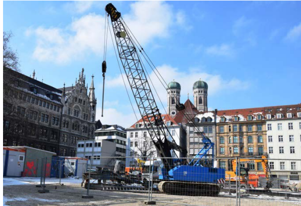
Der Seilbagger für die Brunnenbohrungen wurde bereits am Marienhof angeliefert. (Bild: DB AG / Maximilian Endrös)
