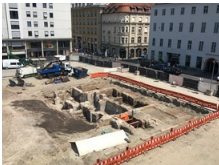
Quelle: DB Netz AG
